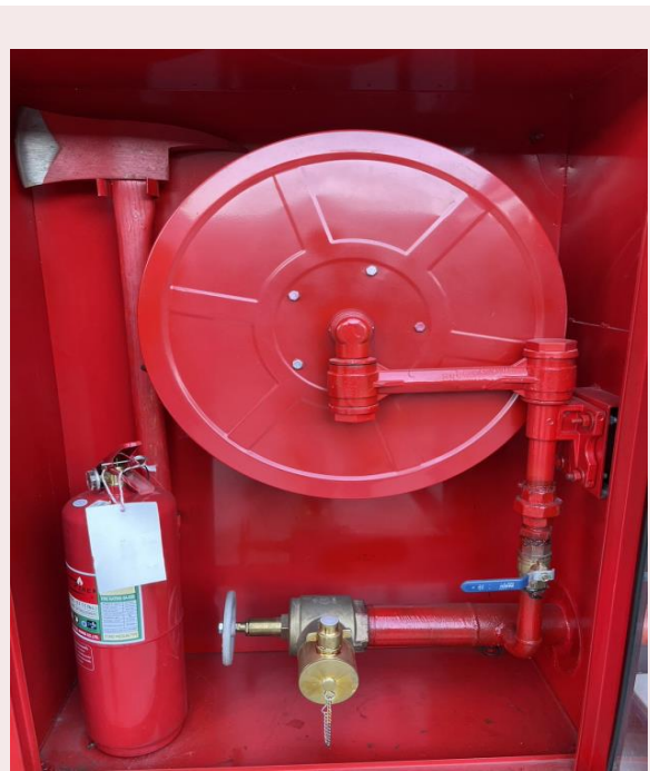
รูปที่ 2.4.6.1-2 ตู้เก็บสายน้ำดับเพลิงพร้อมอุปกรณ์
