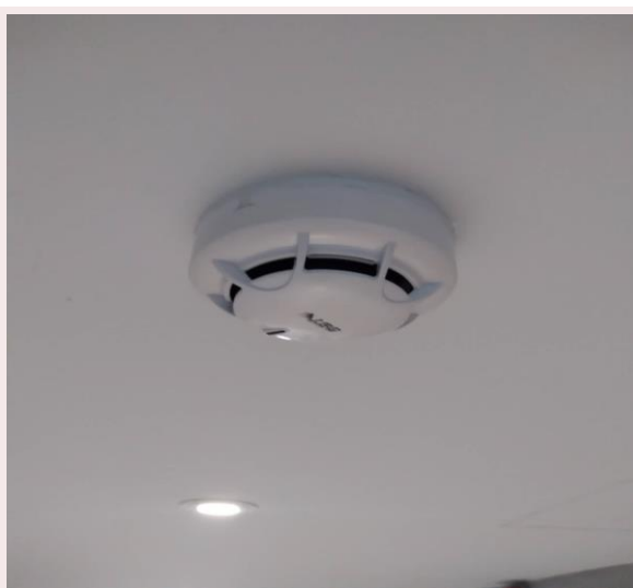
รูปที่ 2.4.6.1-4 อุปกรณ์ตรวจจับควันและความร้อน
